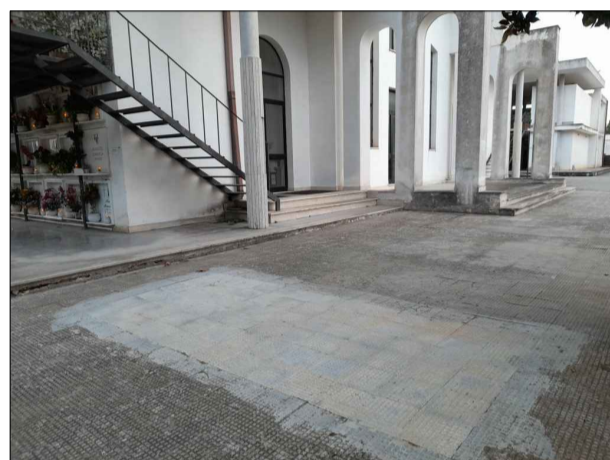
11. L'ingresso alla cappella del cimitero nuovo. Presenza di gradini
