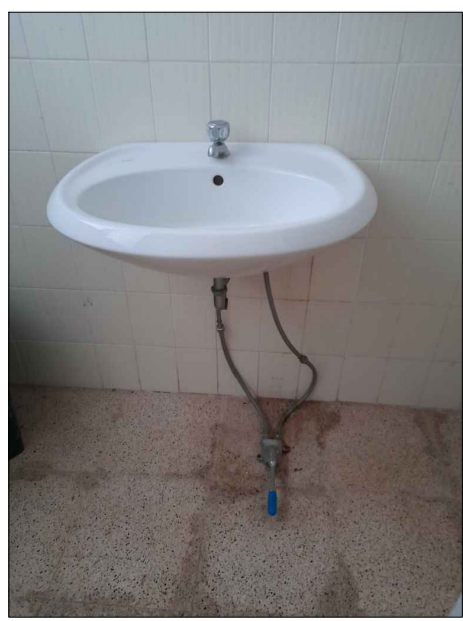
19. Interno dei servizi igienici
