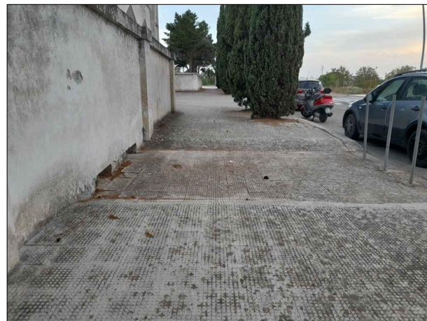
3. Il marciapiede che dal cimitero vecchio porta a quello nuovo. Si noti la forte pendenza dei raccordi dei due livelli del marciapiede
