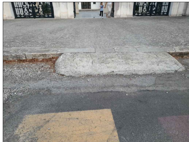
4. La rampa in cemento di ingresso al cimitero nuovo
