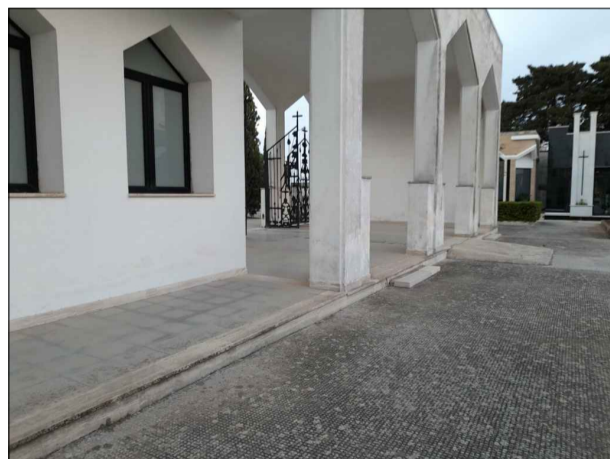
16. Vista del percorso "accessibile" che conduce ai servizi igienici e della rampa (V. foto n.7) per il superamento del dislivello
