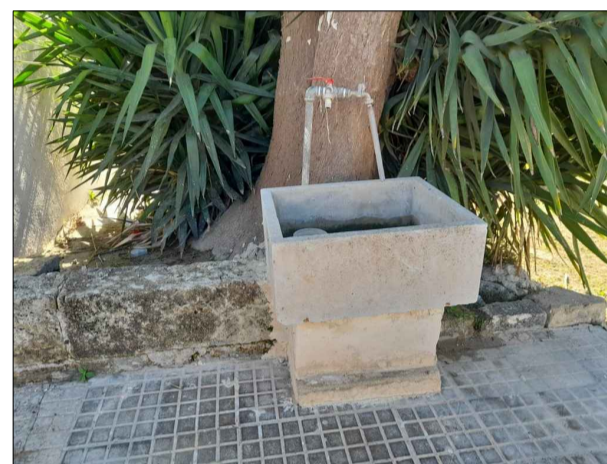
11. Il catino d'acqua con il rubinetto. Il filo superiore del catino è alto 64cm circa da terra, mentre quello inferiore 37cm. Il rubinetto è alto 102cm da terra.
