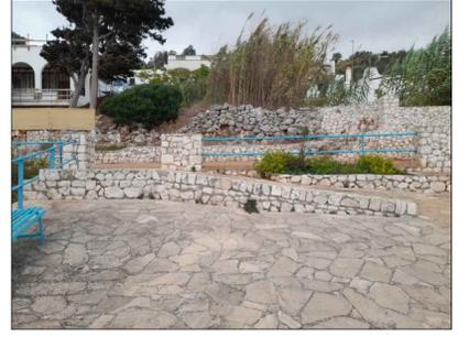
4. Rampa di raccordo tra il livello del lungomare e quello dello spazio di aggregazione; pendenza della rampa circa il 6% cm.
