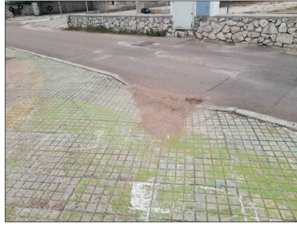
7. Lo scivolo di raccordo tra l'area pedonale e quella carrabile
