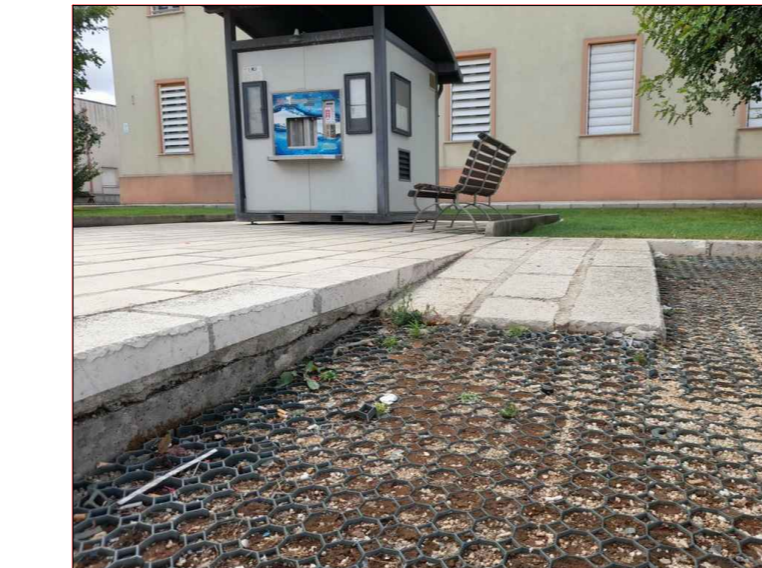
Fontana dell'acqua. Particolare della rampa di raccordo e della pavimentazione
