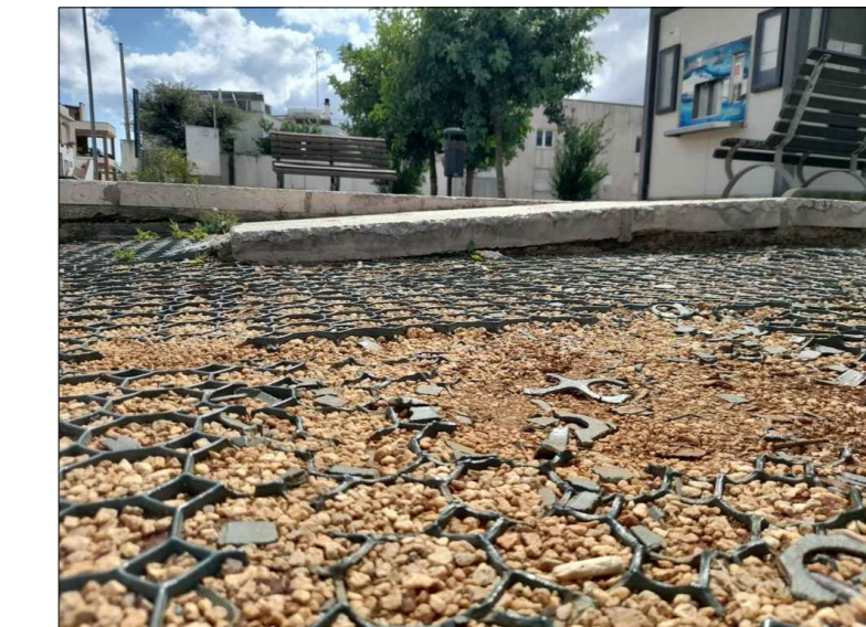
Particolare della pavimentazione del parcheggio
