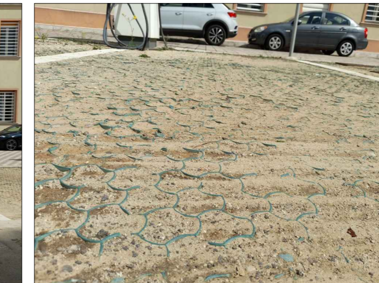
Parcheggio Via Bramante. Particolare della pavimentazione degli stalli riservati ai veicoli elettrici
