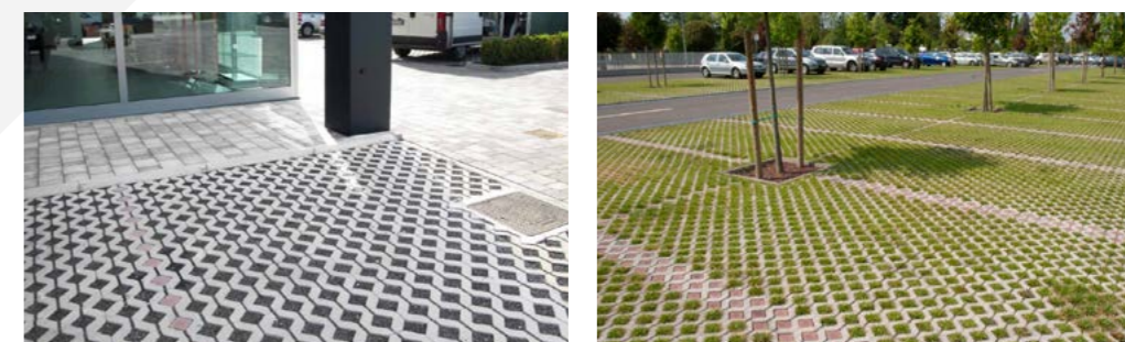
Fig. 7 Esempi di stalli caratterizzati da pavimentazione drenante non accessibile
