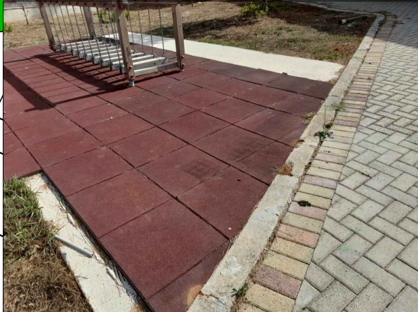
10. Dettaglio dell'attacco pavimentazione fra viale e area giochi (pavimentazione antitrauma)
